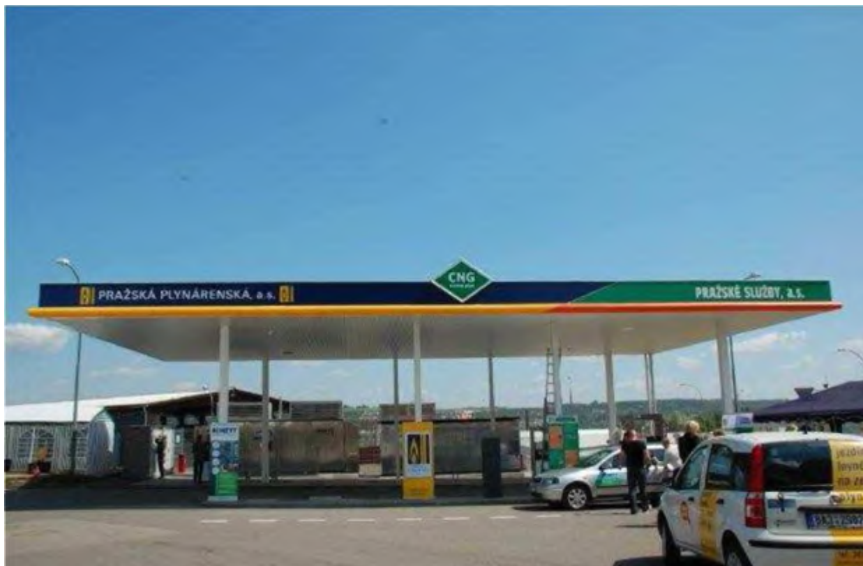
Obr.: Fotka veřejné plnicí stanice v areálu Pražské plynárenské, a.s.
